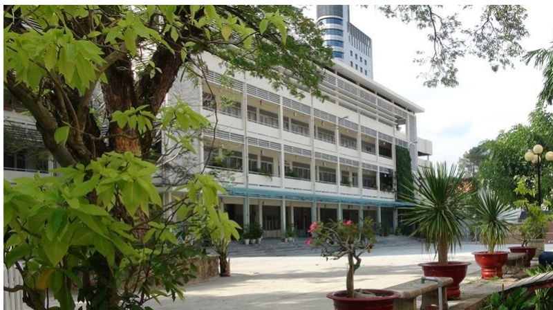
Ngôi nhà được xây dựng năm 1928, được trùng tu năm 1963, đã từng là Tiểu chủng viện Thánh Giuse Sài Gòn, và bây giờ là ngôi nhà của Trung tâm mục vụ TGP. TPHCM.
